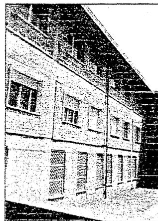
Il piano terra, di più remota costruzione con struttura in c.a. e muratura di tufo non intonacata all'esterno, accessibile dal piazzale mediante gradoni in marmo, è costituito da 5 aule, ampio atrio/disimpegno, locali di servizio ed accessori. Gli infissi interni sono in legno tamburato mentre quelli esterni in ferro con persiane avvolgibili in plastica ed ornate e soglie in lastre di travertino ai vuoti luce. La pavimentazione è in marmettoni 30x30.
