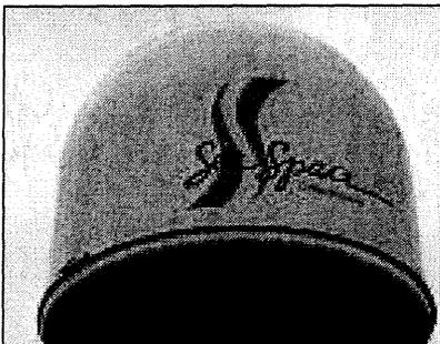
I due sistemi per la ricezione dei dati satellitari sono controllati da computer e hanno una precisione di puntamento di qualche decimo di grado. Il sistema in banda X, è dotato di un'antenna del diametro di circa 4,5 metri con movimento su tre assi. Montata su un alto traliccio, l'antenna è protetta da un "radome" (copertura che lascia passare i segnali elettromagnetici, esteticamente somigliante ad un grande pallone).
