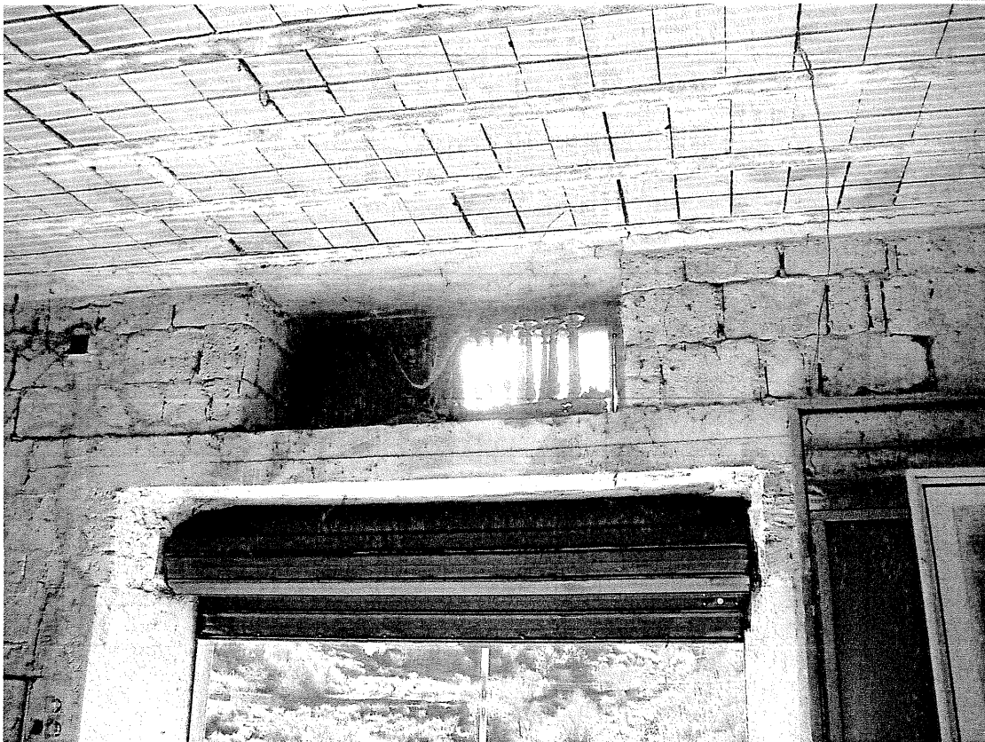
Interno – locale oggetto di intervento
