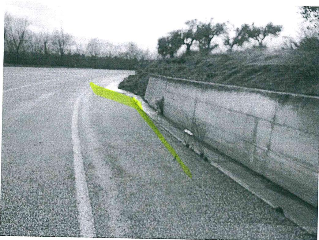
FOTO NUMERO 15 - C.da Piane Smottamento con crollo muro sostegno
