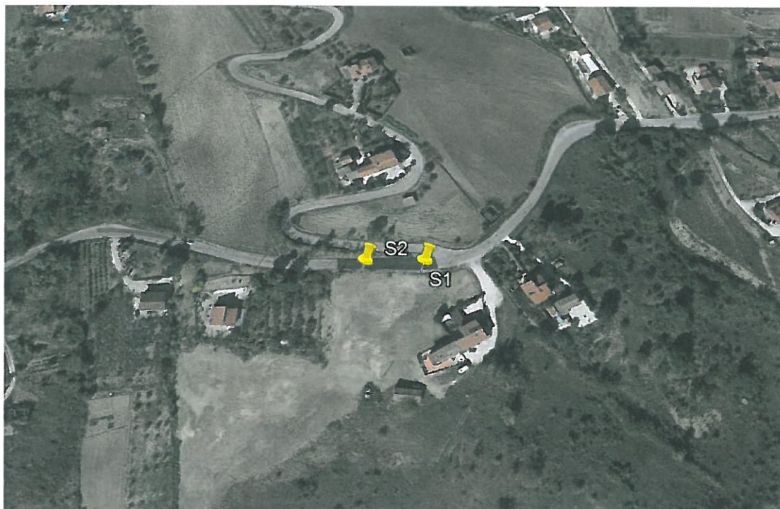
Foto n.°1: Panoramica sondaggi S1 – S2
