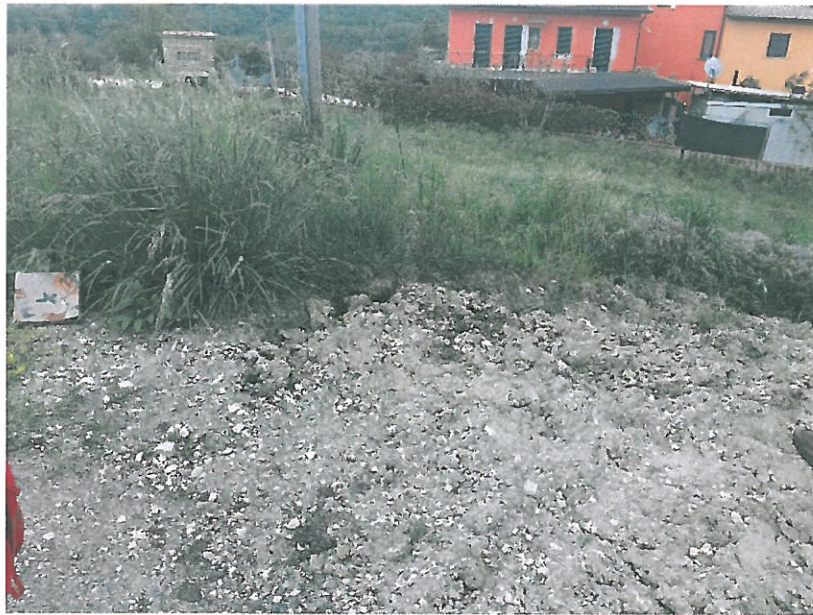
FOTO 3 - Intervento di ripristino della condotta idrica da parte dell'Ente Acquedottistico Alto Calore spa.
