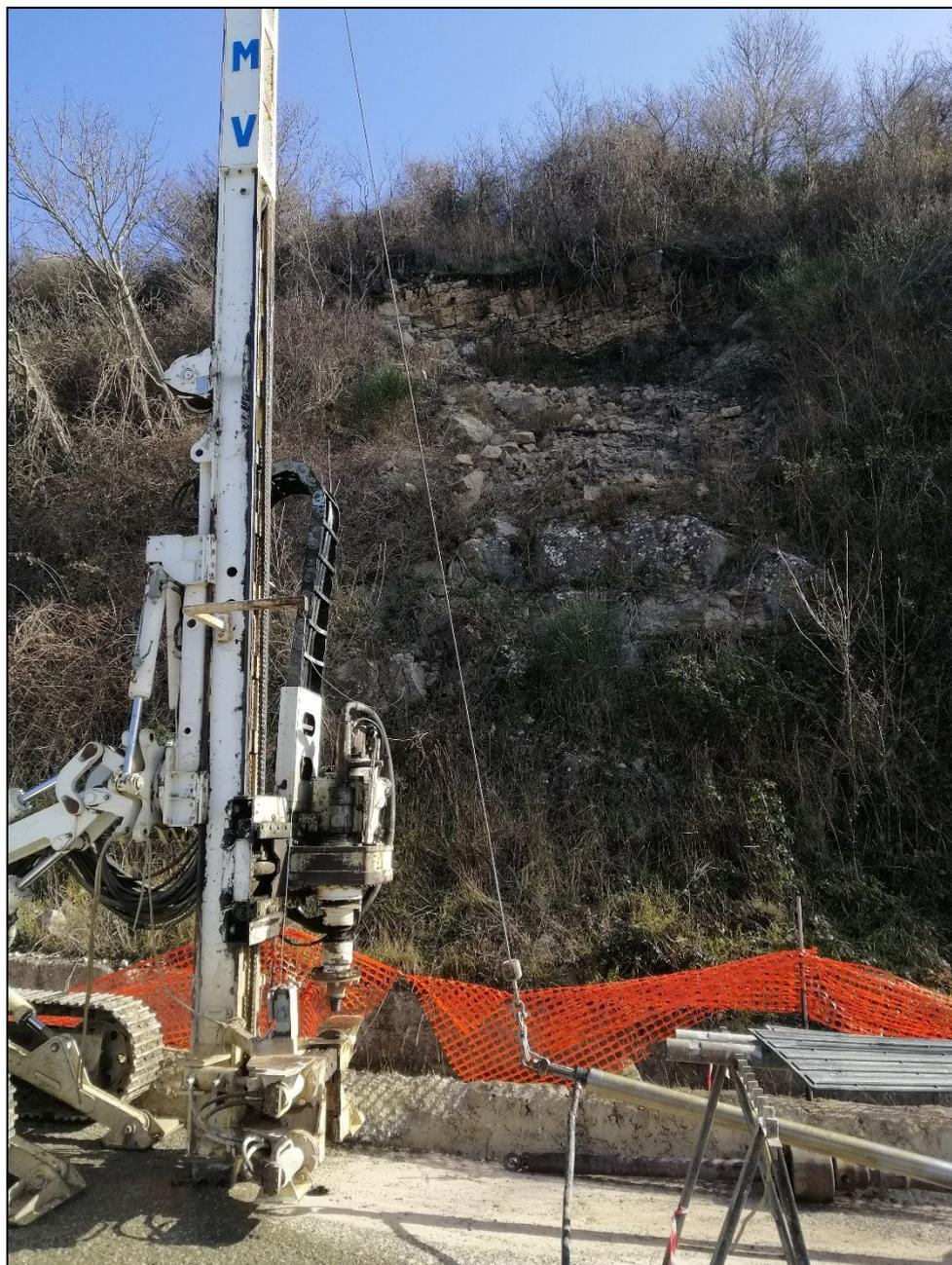
FOTO N. 3: la foto n 3 vuole mettere in evidenza la postazione del sondaggio S.3 rispetto al versante e la dimensione dell'ammasso roccioso in dissesto rispetto alla macchina operatrice.
