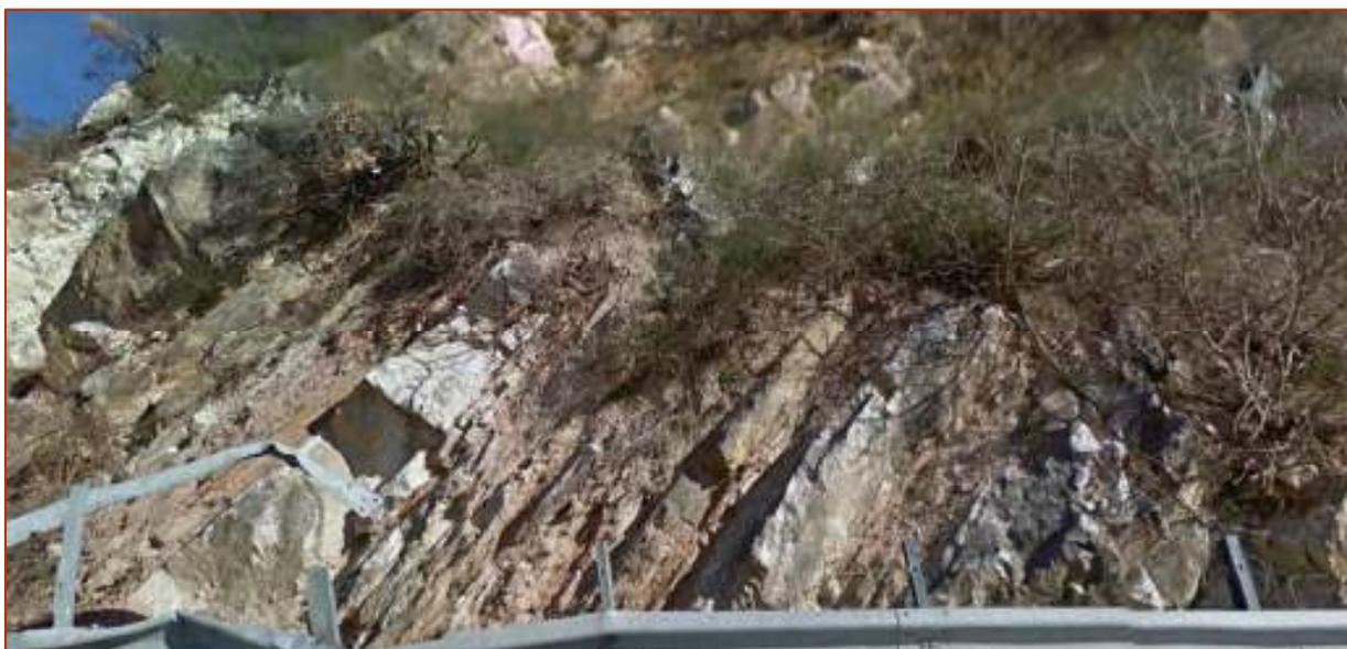
FOTO N.2: dettaglio delle alternanze degli strati calcareo - marnosi ed argillosi disposti a franapoggio rispetto al versante.
