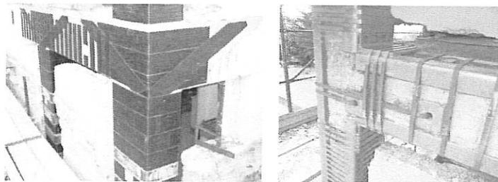
Questi interventi sono volti all'incremento della capacità del pannello nodale nei confronti delle crisi fragili che limitano la prestazione sismica globale della struttura.
