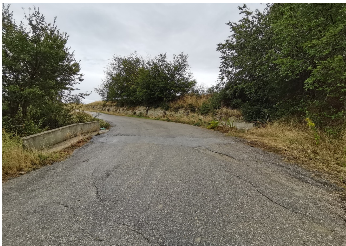
FOTO 4 – Ripristino piano viabile.
