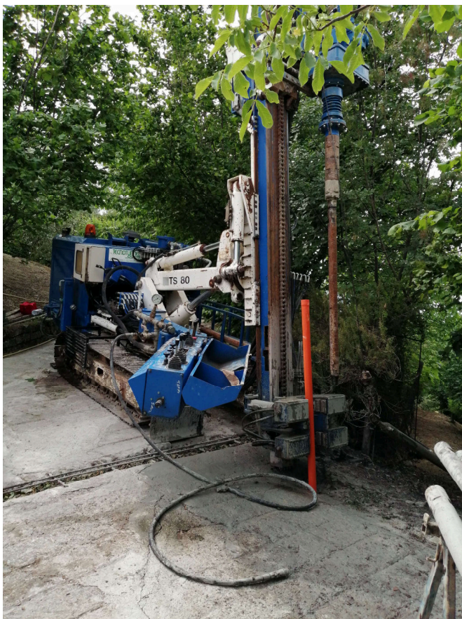
Fig. 13 – Sondaggio S1: installazione del piezometro.
