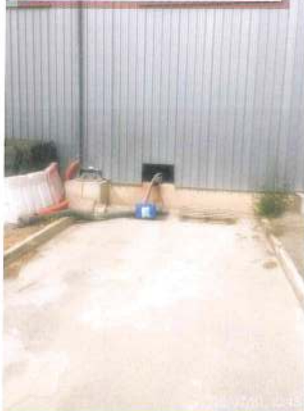
Vista piazzola e presa di carico percolato
