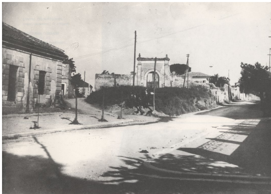
La Caserma Sannitica ai primi del '900, scorcio dell'edificio "B" sul viale degli Atlantici, angolo via T. Ferrelli.
