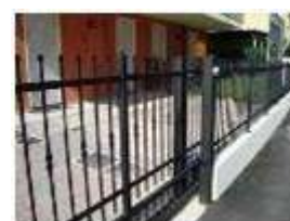
RECINZIONE E OPERE IN FERRO
