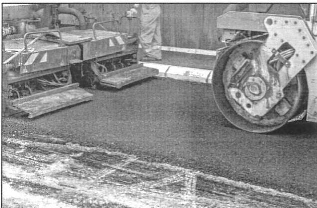
Pertanto si è ritenuto opportuno procedere, per diversi tratti, alla sistemazione del piano viabile con sistemazione e rifacimento del manto di usura con conglomerato bituminoso (tappetino) secondo quanto riportato nel computo metrico di progetto.
