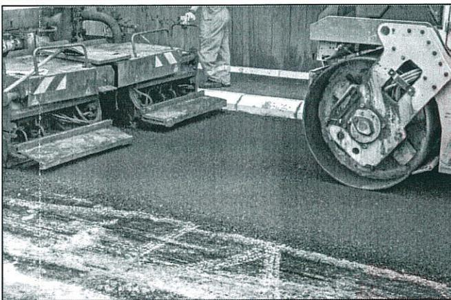
E' stato previsto la fresatura con mezzo meccanico per uno spessore di 3 cm per consentire il mantenimento della quota dei chiusini stradali esistenti e la successiva stesura di conglomerato bituminoso (tappetino).
