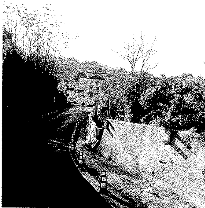
FOTO N.11 – Restringimento della carreggiata
