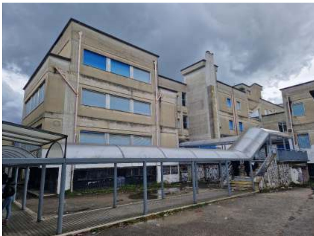
Figura 20 Pensilina di collegamento tra il connettivo e la palestra
