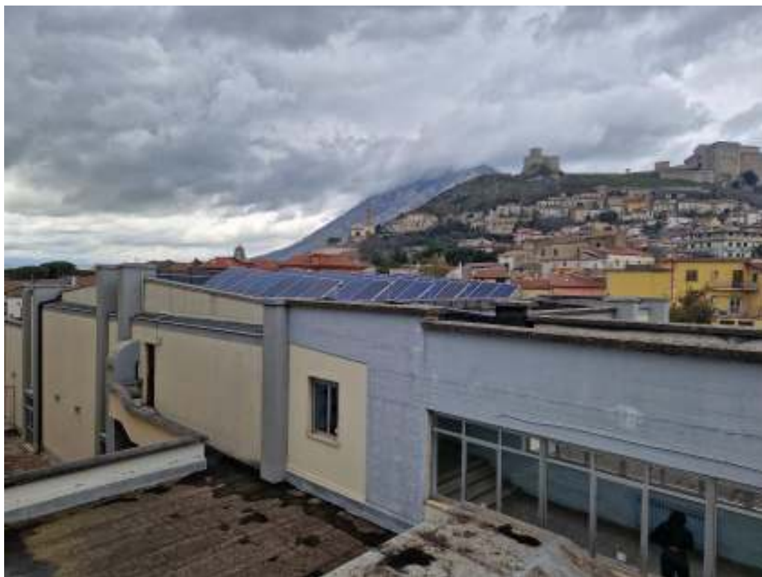
Figura 19 Vista sulla copertura dell'Auditorium
