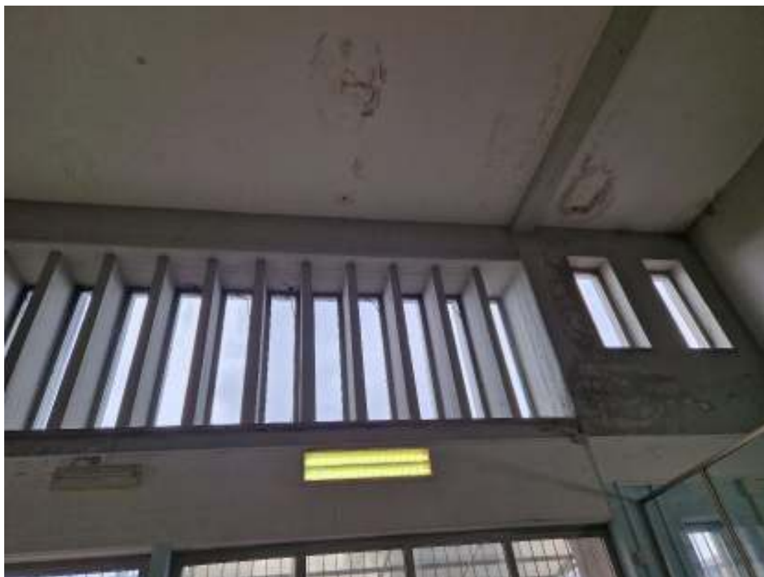
Figura 15 Atrio di ingresso Corpo 1 - particolare della vetrata
